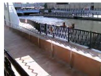
道頓堀川浮庭橋(大阪府)
