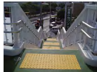
沖縄美里地区歩道橋(沖縄県)
