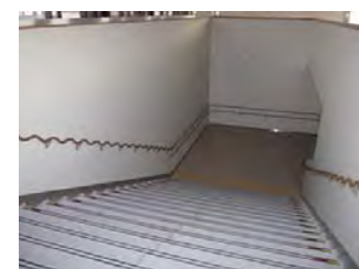
JR浜田駅連絡通路 (島根県)
