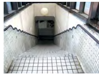
金沢市街地下道(石川県)
