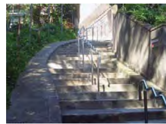
福岡市谷1丁目地内階段(福岡県)
